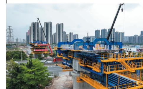
▲多功能悬臂智慧造桥机在深江铁路跨105国道沙溪特大桥上进行作业（3月31日摄，无人机照片）。
