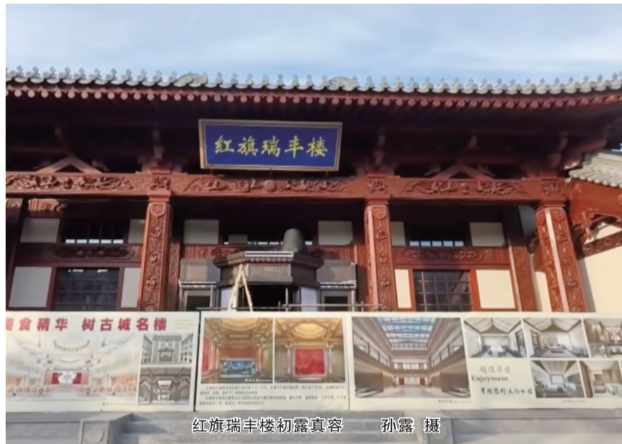
上午，记者从华严广场出发，沿华严寺街向北行至街口，迎面就是大同古城餐饮基地项目的施工现场。记者在现场看到，独具大同地方特色餐饮品牌齐聚于此，这些餐饮酒店内部结构多样，布局各具特色。一家大型酒店在正门上方雕刻了五只凤凰，寓意大同“凤凰古城”，大门上分别雕刻了云冈石窟和悬空寺，酒店内部整体装修风格主要以明清时期为主，彩绘多以金色凤凰为主。在一家以中式快餐为主的餐饮企业施工现场，记者看到该餐饮店采用了北魏时期的建筑风格，独具地域特色的文化符号，让人眼前一亮。同时，古城餐饮基地内还打造了10个清雅名宿为主的明清式院落，院外四周规划风味小吃街，这些院落多采用平雕、浮雕、深浮雕、透雕与窑前雕、窑后雕相结合雕刻工艺，力求在建筑各个方面展现出更多大同民居风貌。
