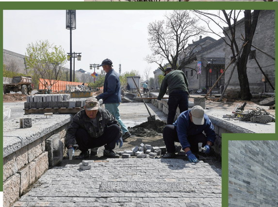
工人铺设水池底部石材
