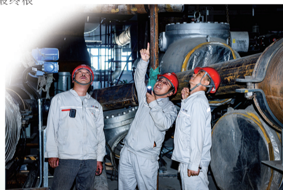
闫宏伟(中)与同事查看汽机房管道
