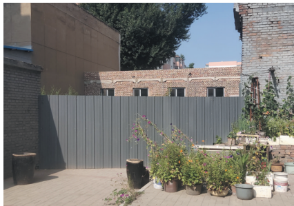
铁板把破损平房与小区隔开 龙中华 摄
